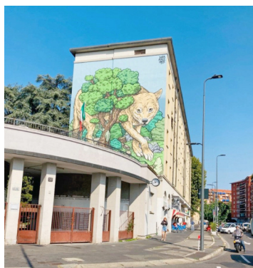
Figura 8 – Il condominio che ospita la Biblioteca Gino Strada
