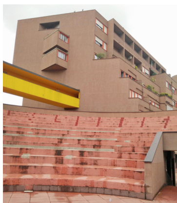
Figura 9 – Il condominio che ospita la Biblioteca condivisa Monte Amiata
