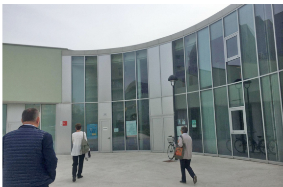
Figura 12 – Biblioteca La conca (esterno)
